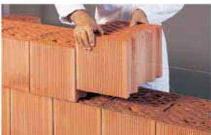
Posa dei blocchi
