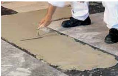
Predisposizione guaina per l'umidità di risalita
