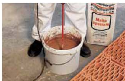
Preparazione della malta speciale
