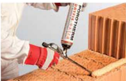
Posa dei blocchi con sistema DRYFIX extra
